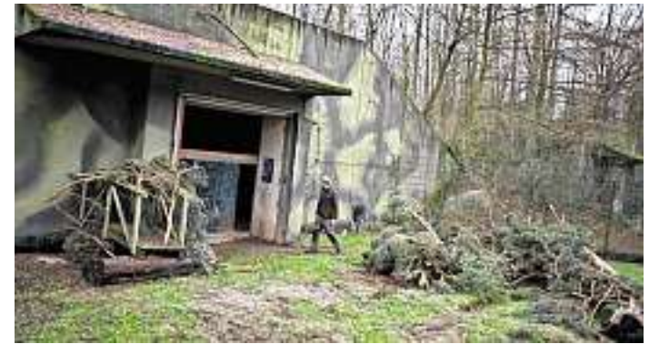
Einer von 26 Bunkern auf der Wildtieranlage.
